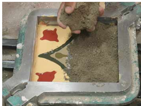
Nach dem Entfernen der Form wird die Nutzschrift mit einer Mischung aus Zement und Felsgranulat bedeckt.
