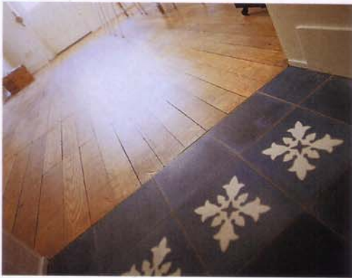
Zwei, die gut zusammenpassen: Holzfußboden und Zementfliesen. Beide sind offenporig und dadurch eine Wohltat für die Füße. (Fliesen: VIA)
